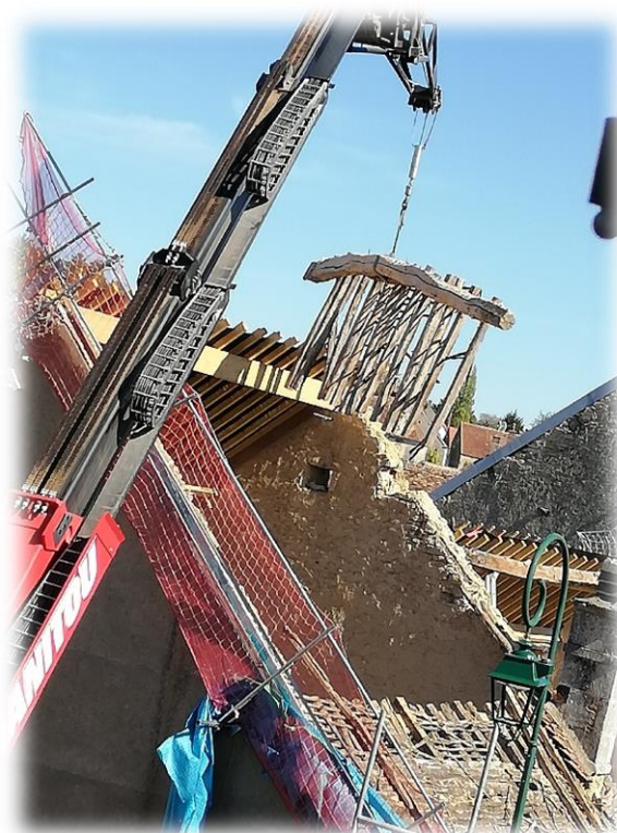
Début du démontage des charpentes
