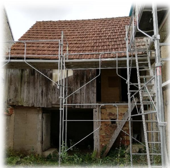
Début du démontage des charpentes
